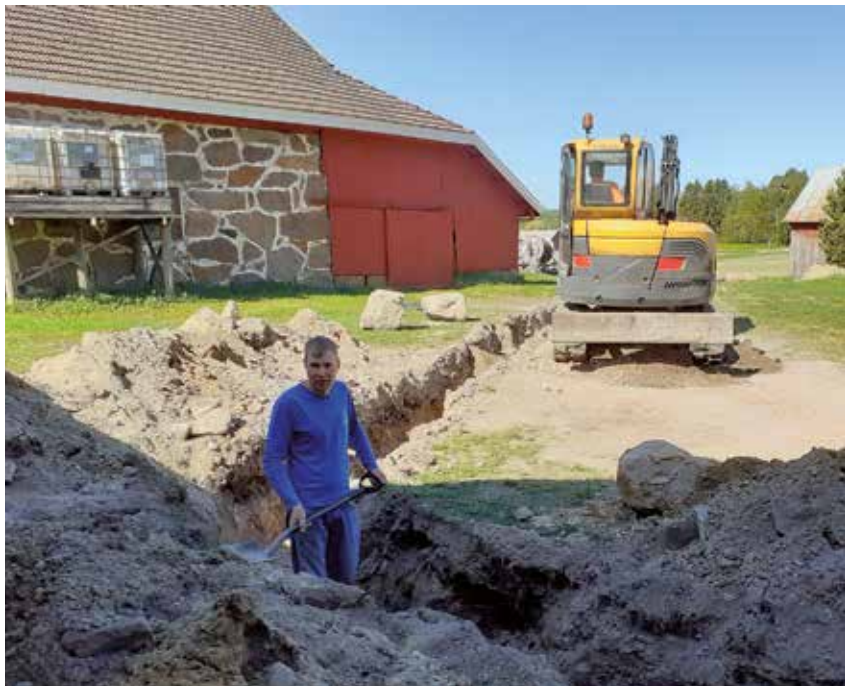
Jussi Vianto näytti toukokuussa, kuinka tontilla vedettiin maakaapelia.
