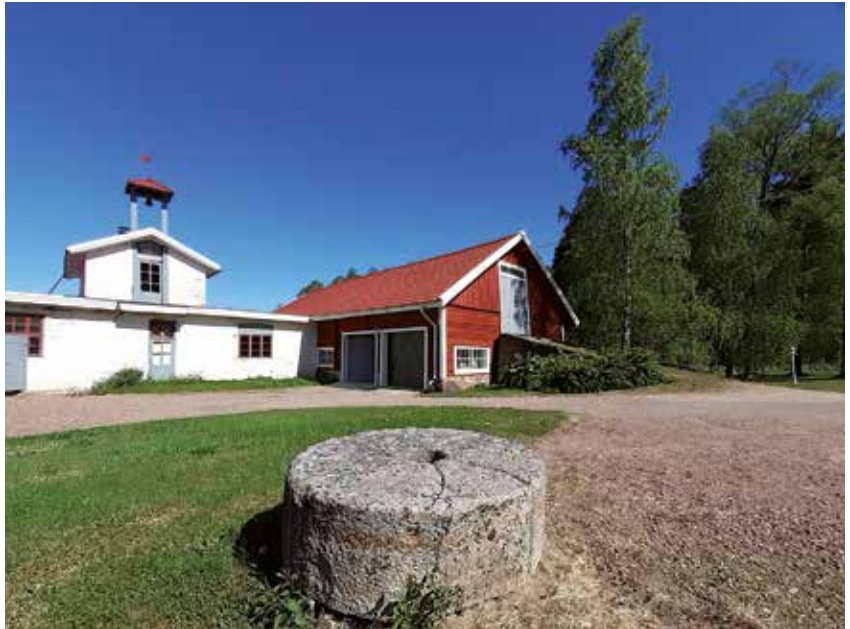
Lähteenmäen tilalla on säilynyt vanhaa rakennuskantaa.
